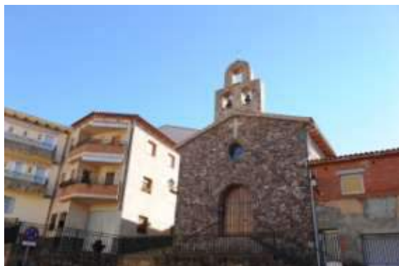
Vista de la fachada principal y el lienzo W
