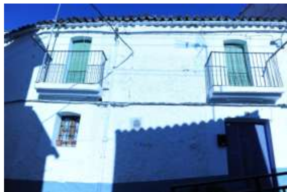
Vista de fachada principal
