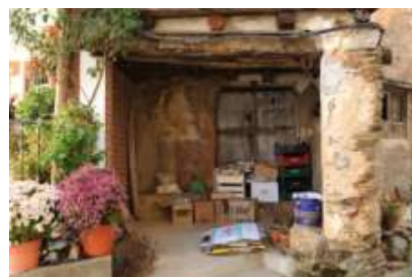
Detalle de porche de entrada
