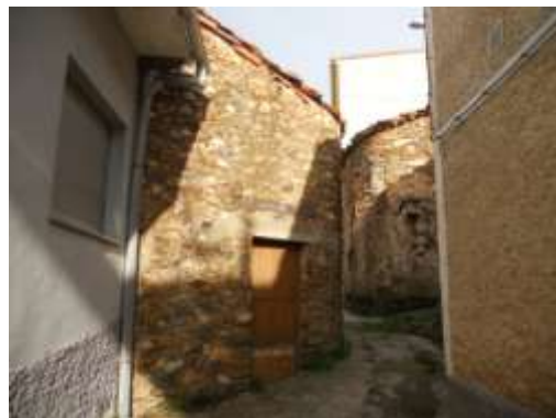
Vista de fachada N y balcón
