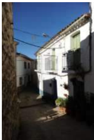
Vista de fachada principal desde el E
