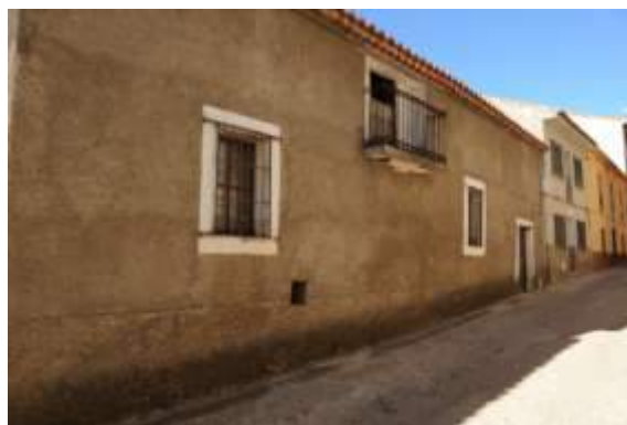
Vista de la fachada desde el S
