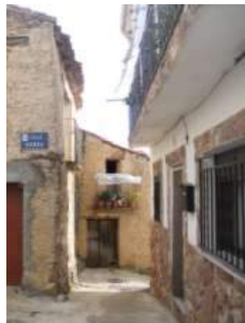
Vista de fachada N y balcón
