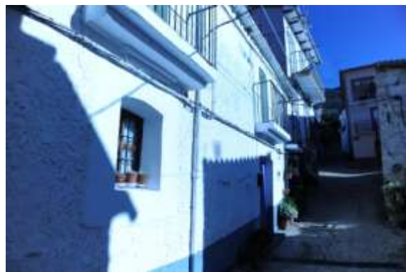
Vista de fachada principal desde el W
