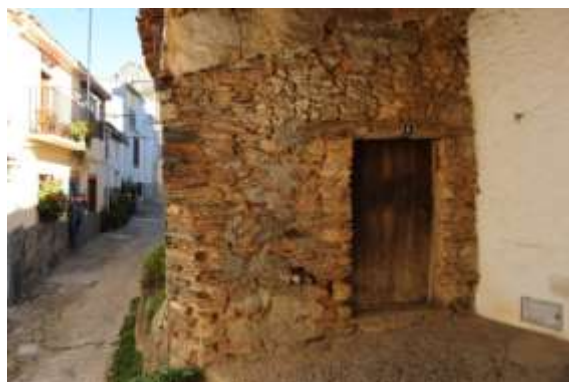
Vista porche de entrada nº8
