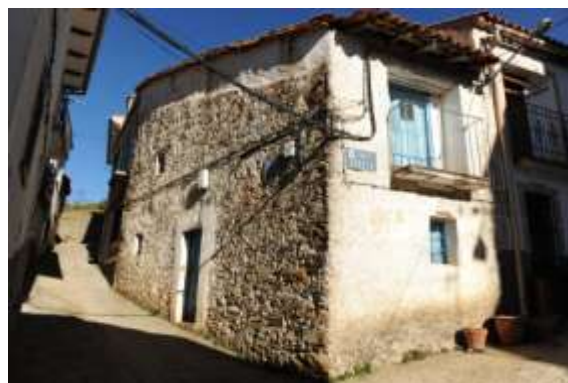
Vista desde la calle Arroyo
