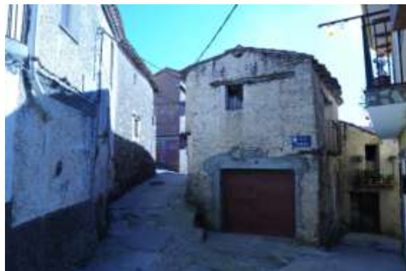
Vista de fachada N y balcón W
